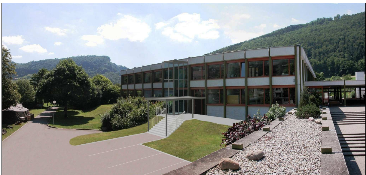
Anlage Brühl – Osttrakt – mit neuer Eingangspartie und Aussenlift
